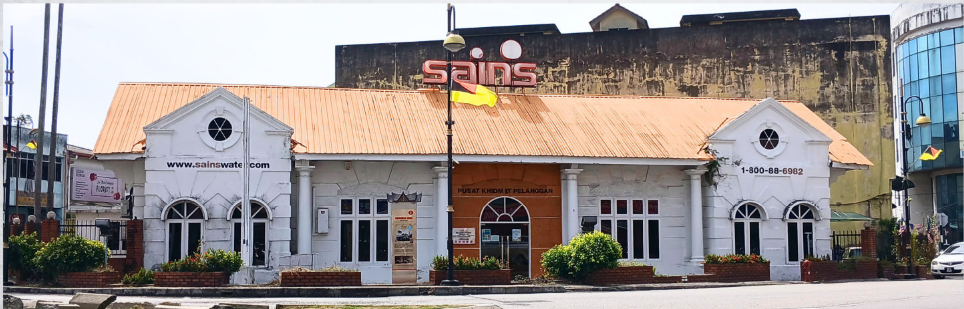
Figure 2.2.1 Main facade of SAINS Seremban, 310A, Jalan Dato Bandar Tunggal, Bandar 70000, Seremban, Negeri Sembilan
