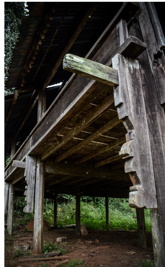
Gambar 18 Struktur tiang dengan kaedah tanggam dan pasak dan dihias dengan tetupai pada bahagian Serambi
