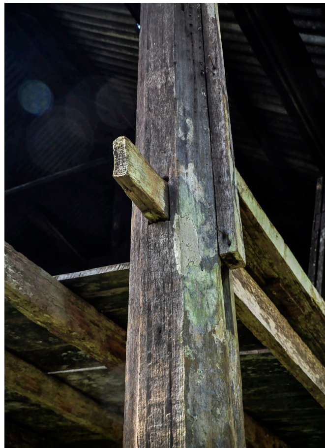
Gambar 17 Struktur tiang dengan kaedah tanggam dan pasak pada bahagian rumah Ibu.
