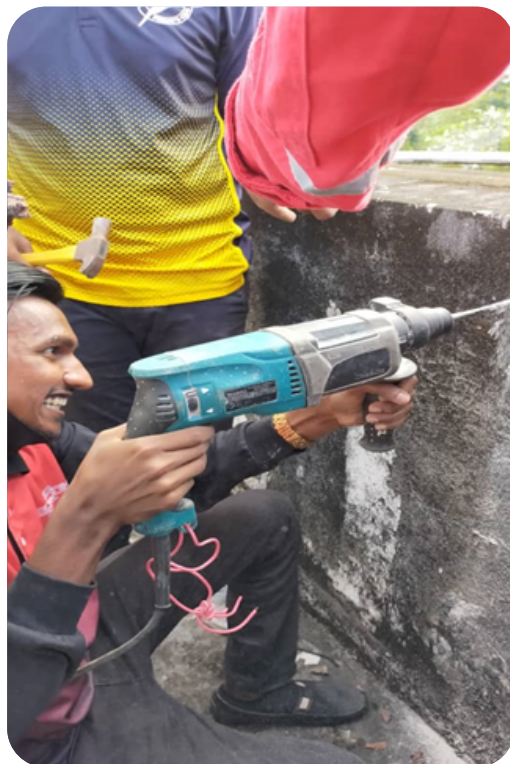
Sesi pemasangan tapak lampu solar
