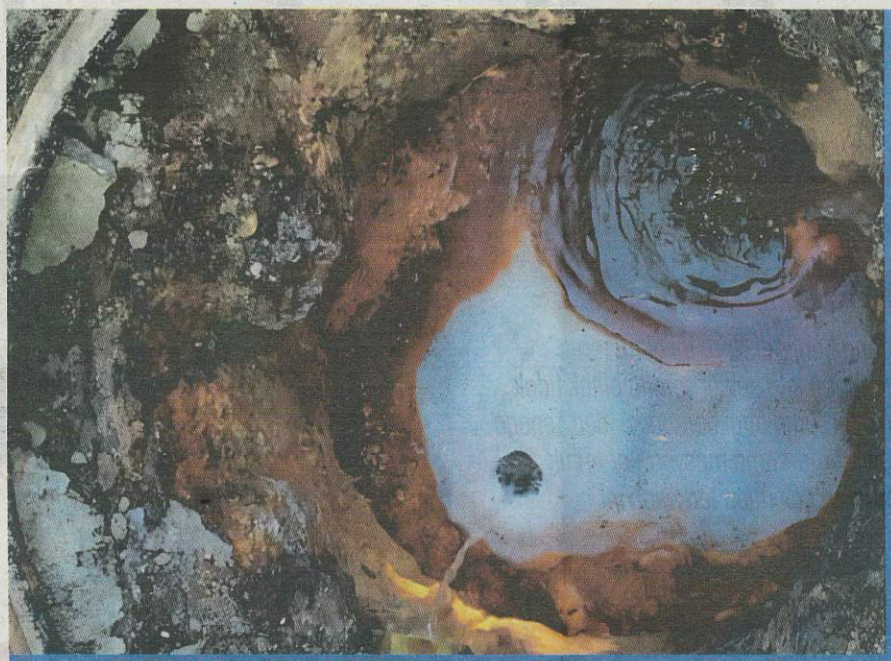
Sisa minyak dan lemak yang terkumpul di dalam lurang kumbahan.
