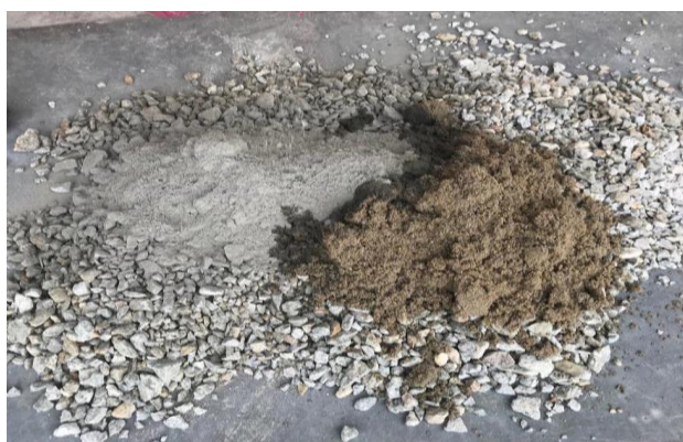
Rajah 3.1: Percampuran Kering Bahan-Bahan Bancuhan
