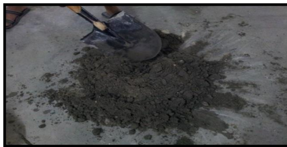
Rajah 3: Proses Menggaul Campuran Bata
