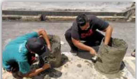
Pelajar-pelajar membina bangku simen fero untuk diletakkan di sudut sihat
