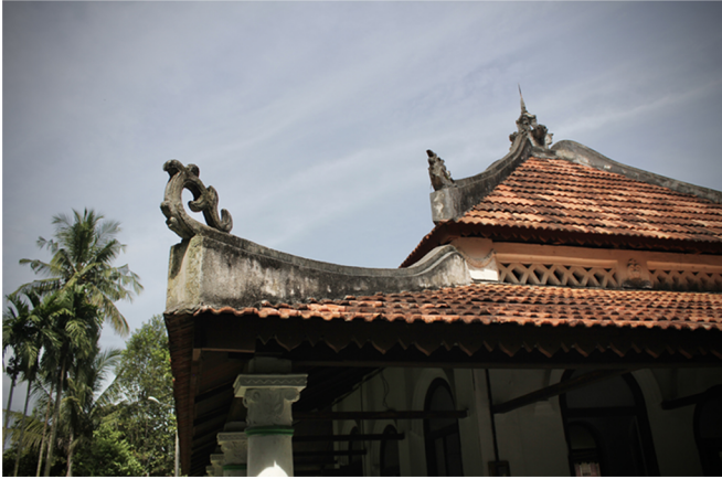
Gambar (19), pandangan sudut bumbung hadapan.
