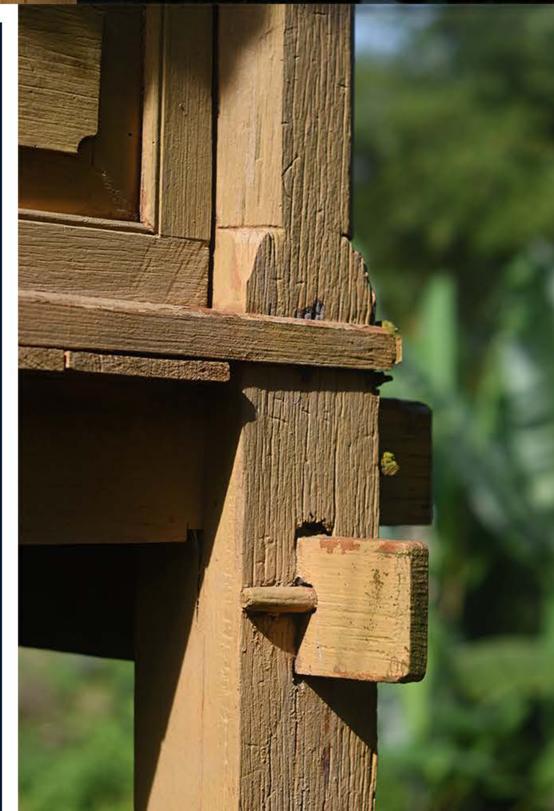
Gambar 24 , Struktur tiang dengan kaedah tangam dan pasak pada bahagian tiang masjid ini . Tiang yang menjadi struktur yang menahan bebanan pada Masjid Lama Kg. Kuala Serdang.
