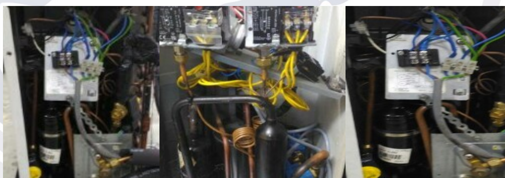
Rajah 3 : Penyambungan Wayar Pada Unit Luar
