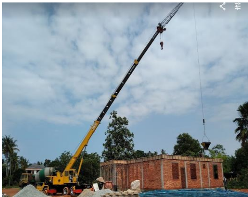
Rajah 66: Kerja-kerja konkrit roof beam sedang dijalankan
