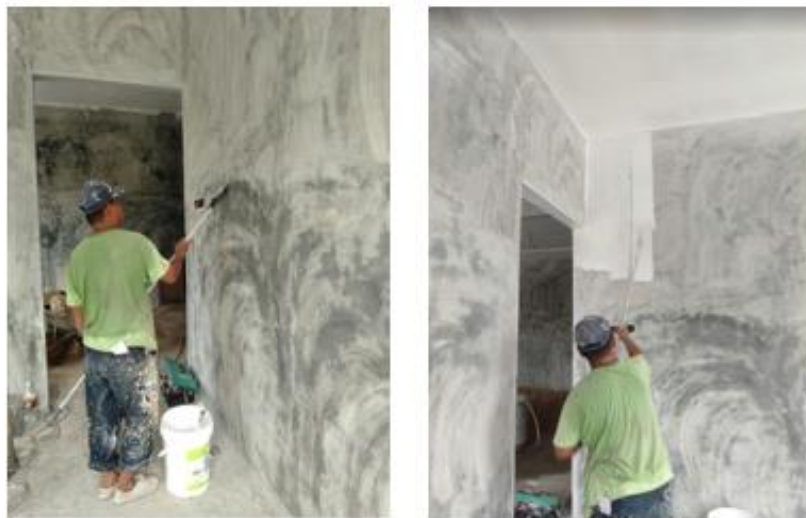
Rajah 104: Kerja-kerja membersihkan permukaan dinding dan mengecat lapisan sealer sedang dijalankan.
