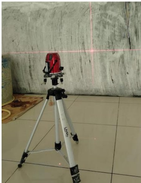
Rajah 5: Penggunaan laser dalam menentukan aras lantai
