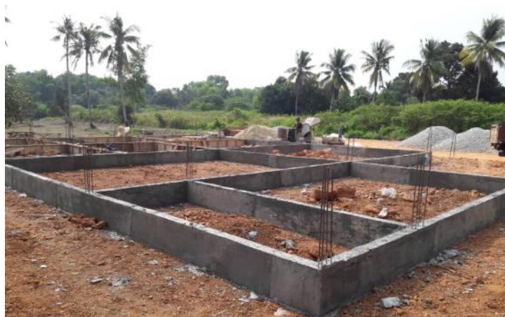
Rajah 35: Ground Beam yang sudah siap dikongkrit
