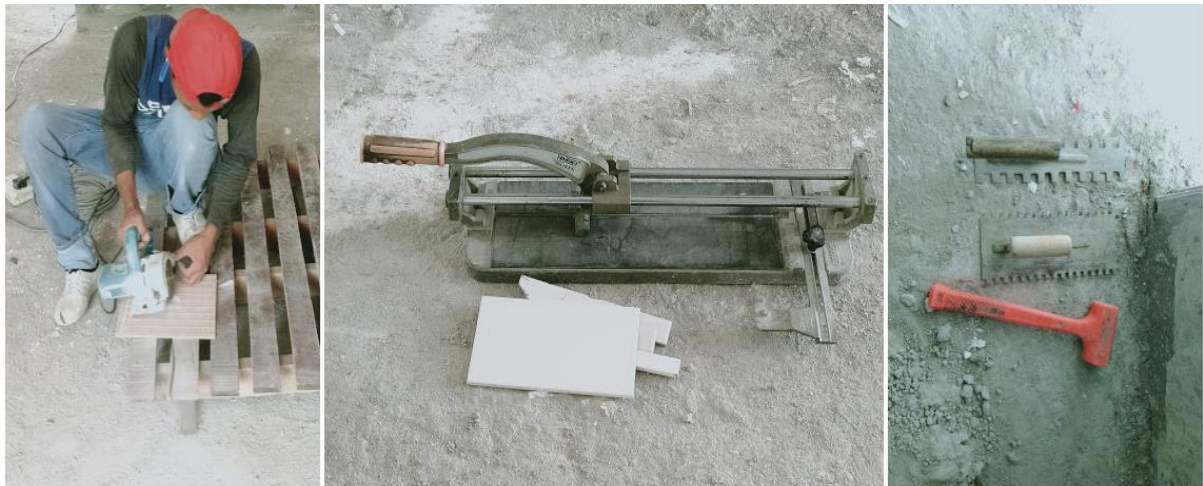
Rajah 105: Peralatan yang digunakan semasa kerja-kerja pemasangan jubin
