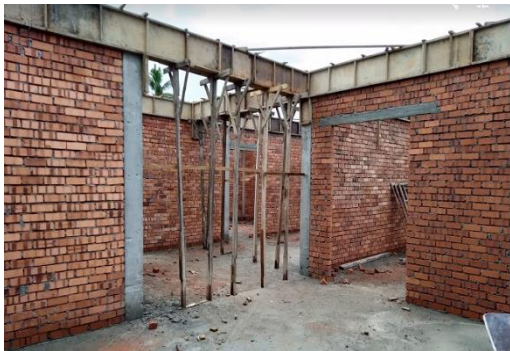
Rajah 65: Contoh penyediaan formwork roof beam di tapak bina
