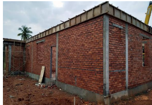
Rajah 65: Contoh penyediaan formwork roof beam di tapak bina
