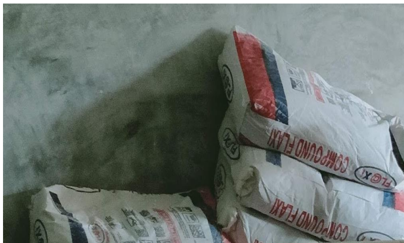
Rajah 99: Contoh jenis simen yang digunakan untuk melepa sambungan siling kapur
