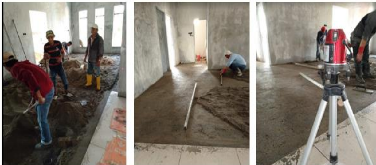
Rajah 104: Kerja-kerja screed lantai sedang dijalankan
