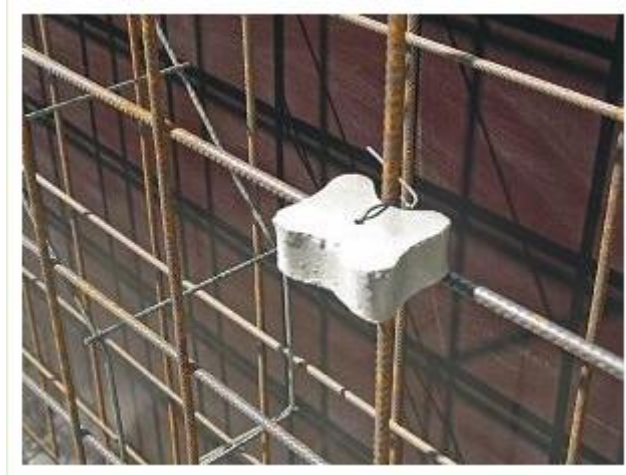
Rajah 10: Contoh penutup konkrit di pasang pada tetulang besi.
