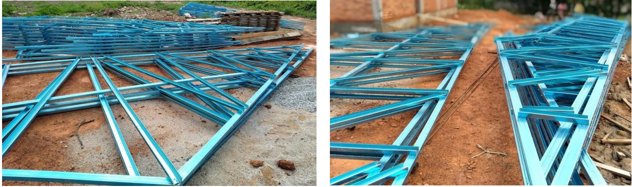
Rajah 71: Pembinaan struktur kekuda bumbung di tapak bina
