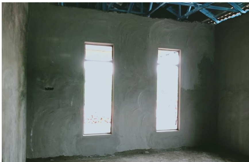
Rajah 94: Contoh lapisan Kemasan Licin yang siap.
