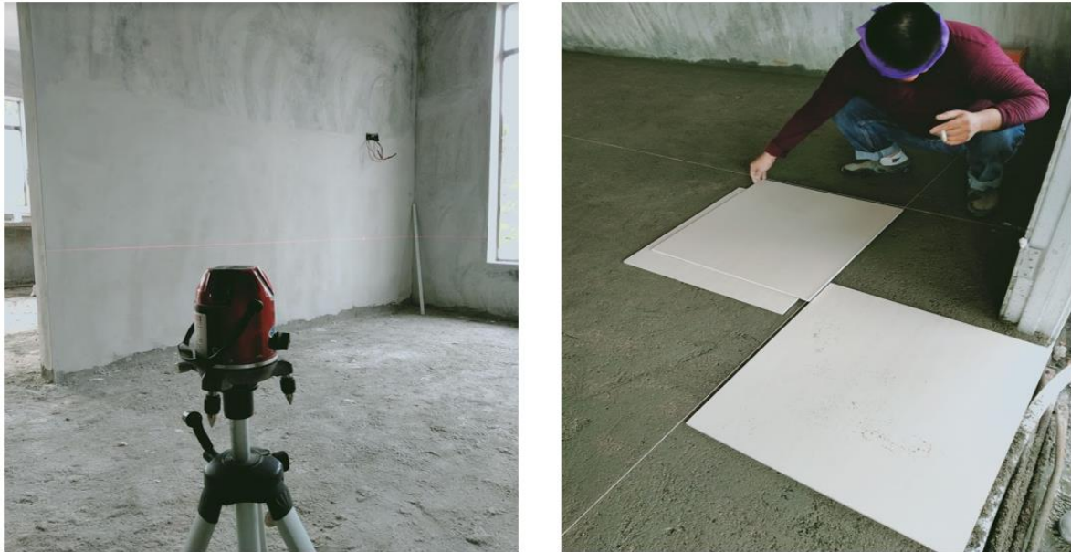
Rajah 103: Kerja-kerja mengukur aras lantai dan siku pemasangan lantai
