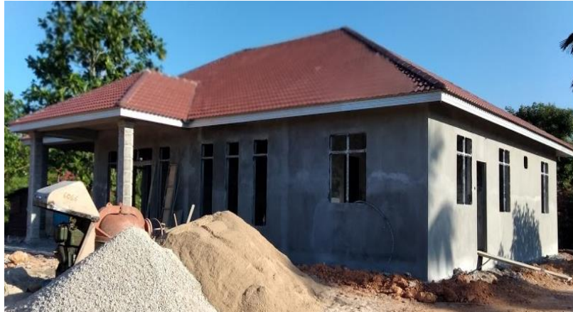
Rajah 81: Rumah yang sudah siap kerja-kerja bumbung termasuk pemasangan aksesorinya.
