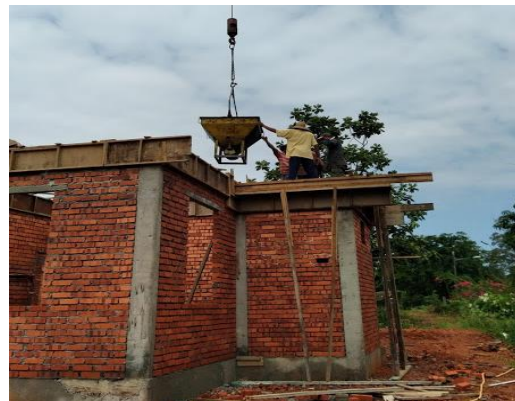
Rajah 66: Kerja-kerja konkrit roof beam sedang dijalankan
