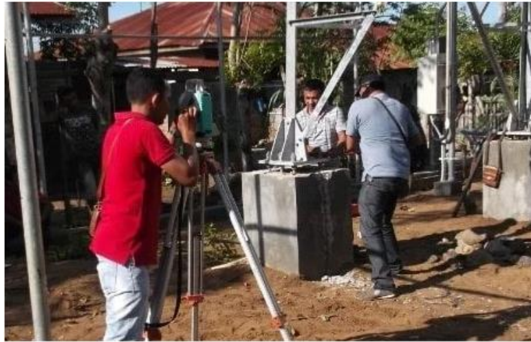
Rajah 4: Penggunaan Theodolite dalam menentukan tegak tiang besi
