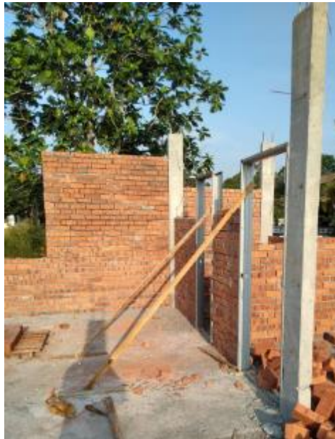
Rajah 54: Kerangka pintu yang telah di'kunci'
