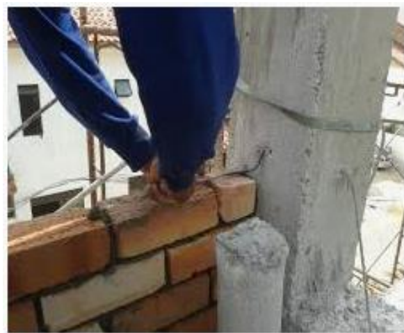
Rajah 62: Ikatan batu-bata disambung dengan besi pada tiang konkrit.
