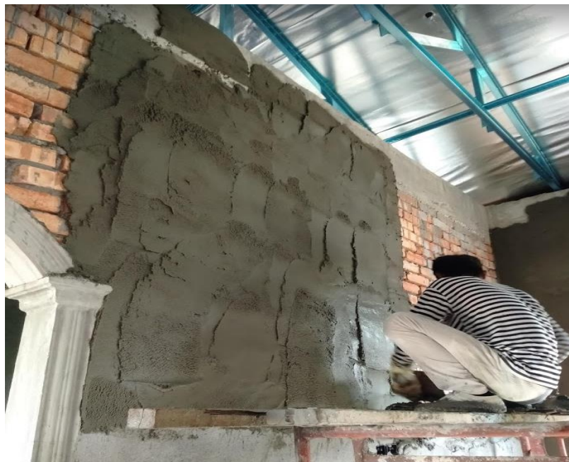
Rajah 92: Kerja-kerja melepa dinding lapisan kasar.
