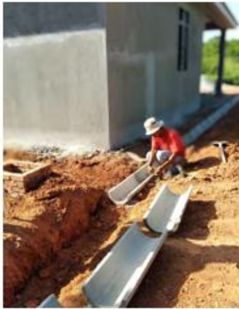
Rajah 109: Kerja-kerja pemasangan longkang dan kaki lima sedang dijalankan
