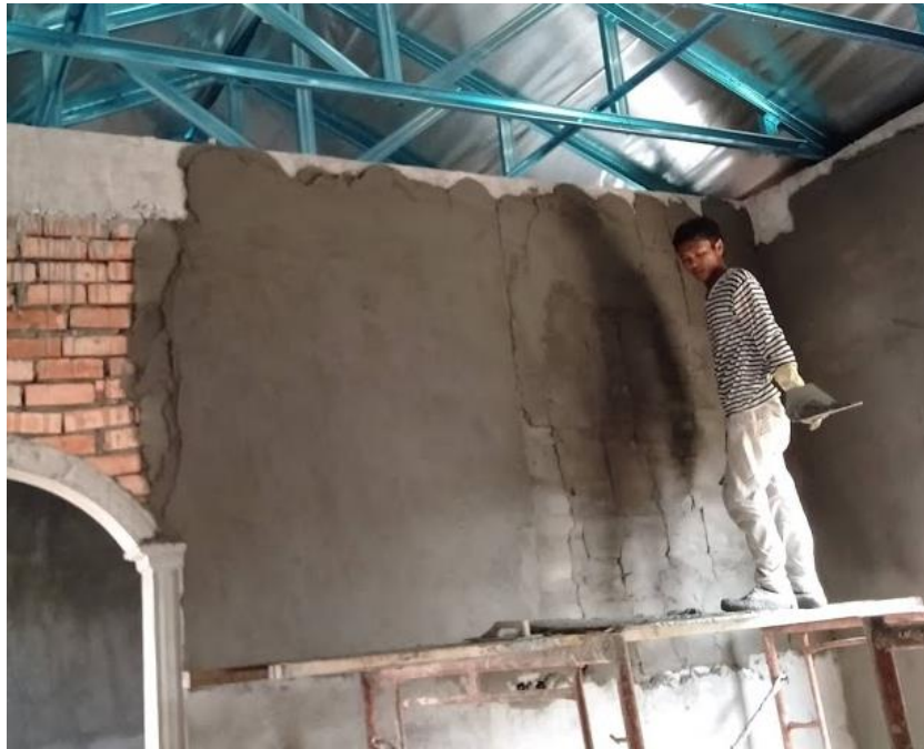
Rajah 93: Kerja-kerja Lapisan kedua (Rata)
