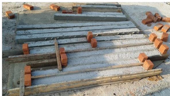
Rajah 63: Contoh pembinaan lintel di tapak bina
