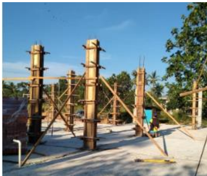
Rajah 48: Kerja-kerja mendirikan dan tupang tiang sedang dilakukan
