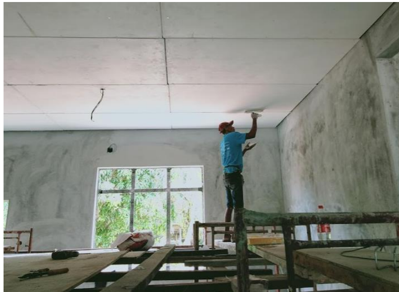
Rajah 100: Kerja-kerja melepa sambungan siling kapur
