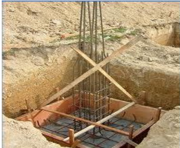
Rajah 31: Pemasangan besi asas tapak
