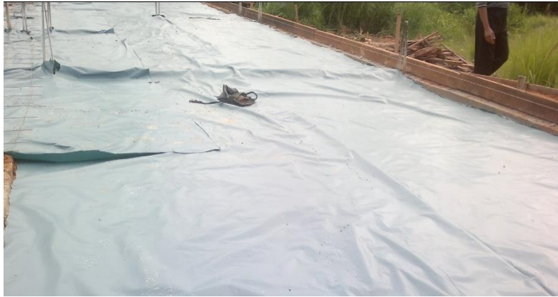
Rajah 40: Lapisan plastik diletakkan
