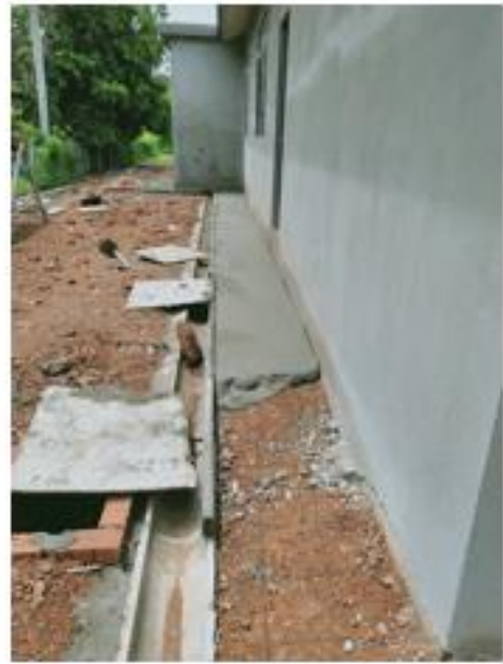
Rajah 109: Kerja-kerja pemasangan longkang dan kaki lima sedang dijalankan
