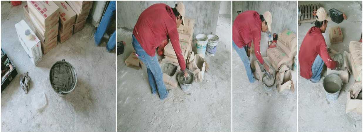
Rajah 106: Kaedah bancuhan simen untuk pemasangan jubin dinding
