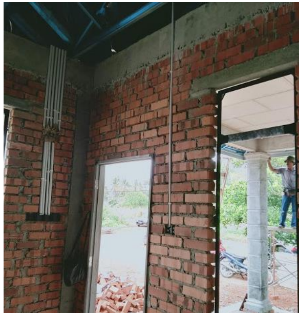
Rajah 85: Kerja-kerja pemasangan paip elektrikal
