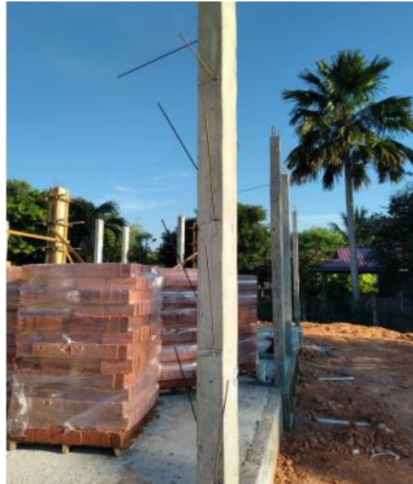
Rajah 49: Besi jenis R bersaiz 6mm diletakkan pada tiang untuk mengukuhkan ikatan batu-bata pada tiang.
