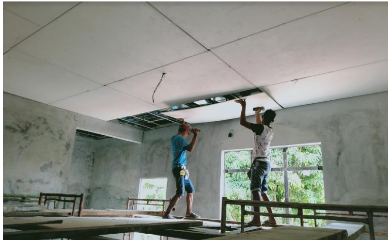
Rajah 98: Kerja-kerja pemasangan siling kapur sedang dijalankan.
