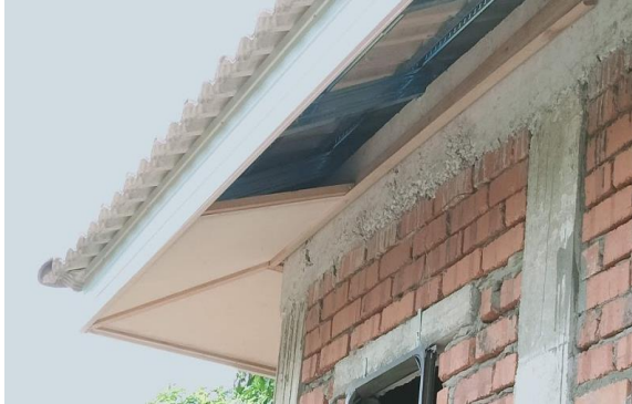
Rajah 87: Kerja-kerja pemasangan siling luar
