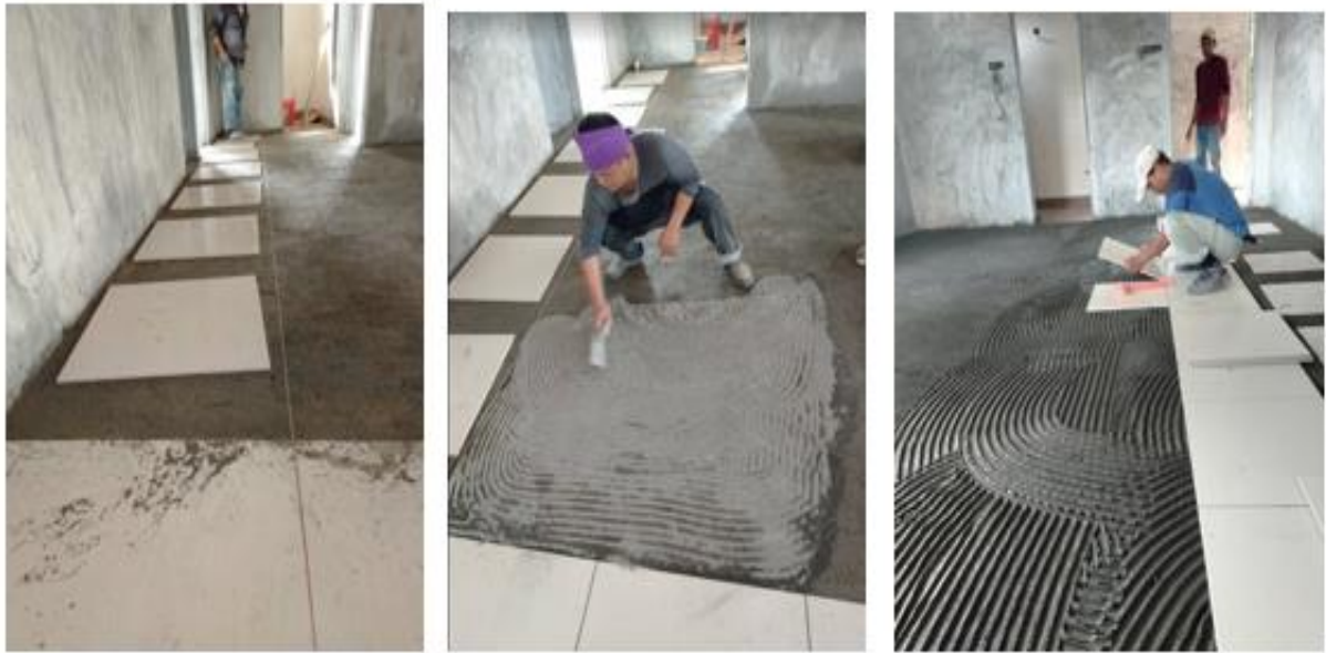
Rajah 104: Kerja-kerja pemasangan jubin lantai sedang dijalankan
