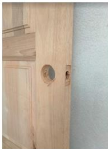
Rajah 103: Kerja-kerja pemasangan pintu dan kunci pintu
