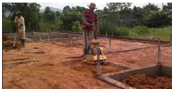
Rajah 39: Kerja-kerja memampat tanah sedang dilakukan
