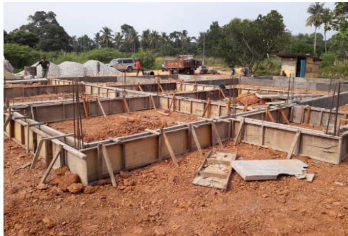
Rajah 34: Framework Ground beam yang sudah siap dipasang
