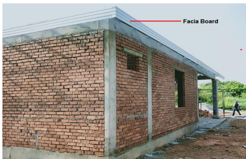
Rajah 77: Penggunaan jenis metal fascia dari GI sheet untuk Facia Board
