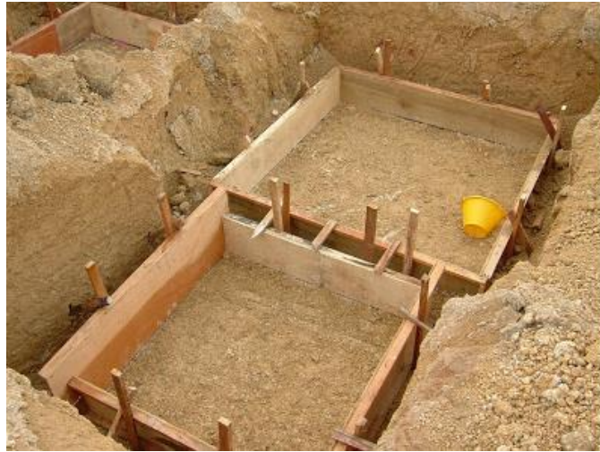
Rajah 29: Pemasangan kotak bentuk asas tapak
