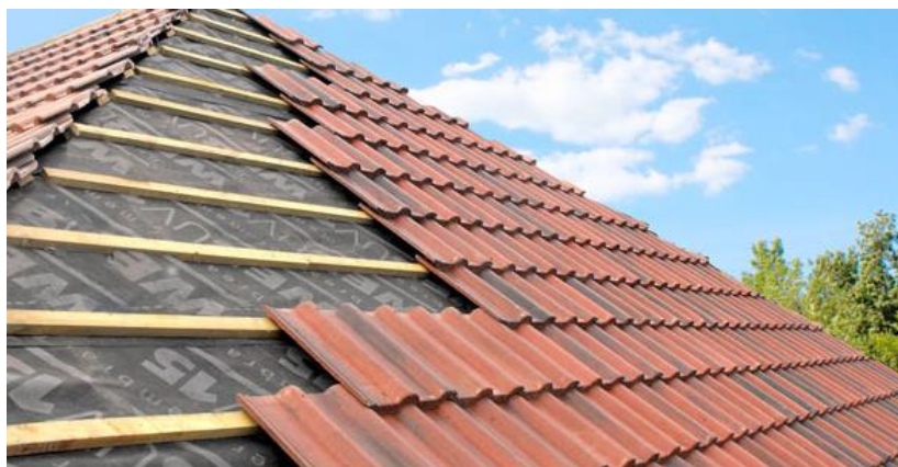
Rajah 80: Contoh penyusunan genting bumbung
