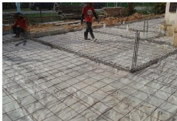
Rajah 13: Penggunaan BRC pada lantai bawah
