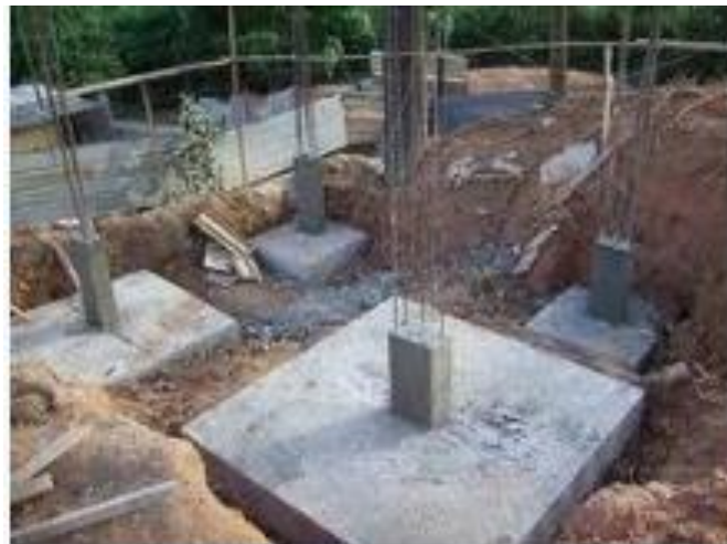
Rajah 32: Setelah kerja-kerja konkrit asas tapak selesai
