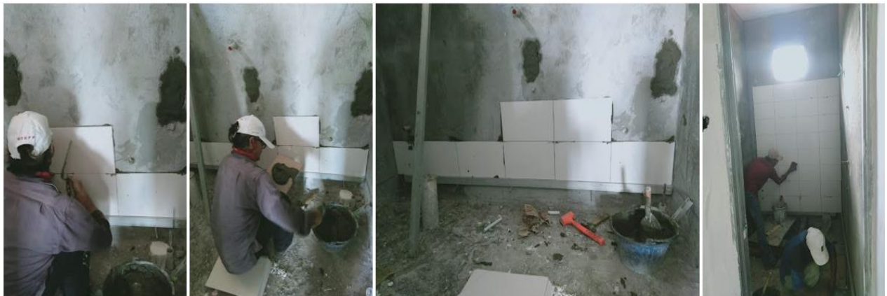
Rajah 107: Kerja-kerja pemasangan jubin dinding sedang dilakukan
