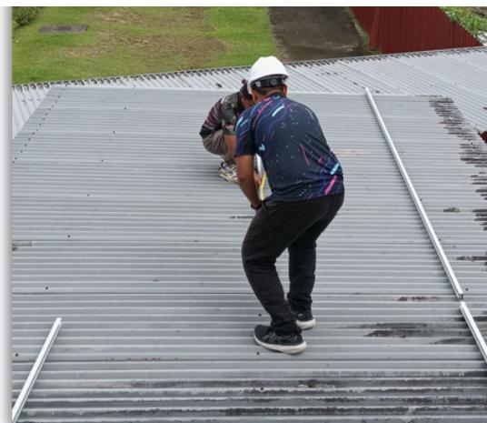
Rajah 4.2: Pemasangan Railing
