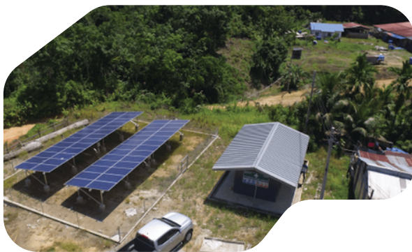
Rajah 1.1: Mini Off Grid, Tatau, Bintulu
