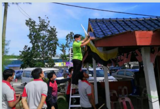
Aktiviti pemasangan solar panel di bahagian bumbung pondok
