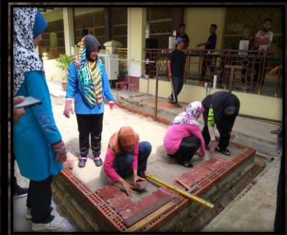
Pemasangan interlocking concrete paver
