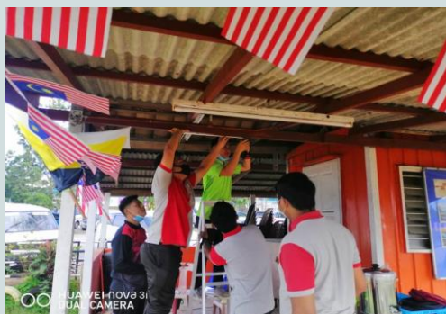
Aktiviti kursus pemasangan dan penyelenggaraan lampu solar
