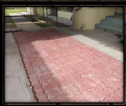
Lokasi sebelum dan selepas pemasangan interlocking concrete paver
