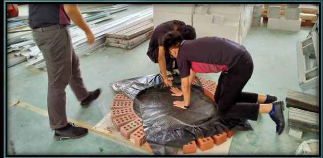
Kerja pembuatan meja simen fero
