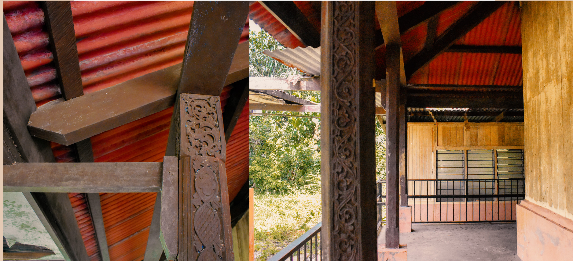
Gambar 14 | Struktur tiang dengan kaedah tanggam dan pasak pada bahagian serambi.
