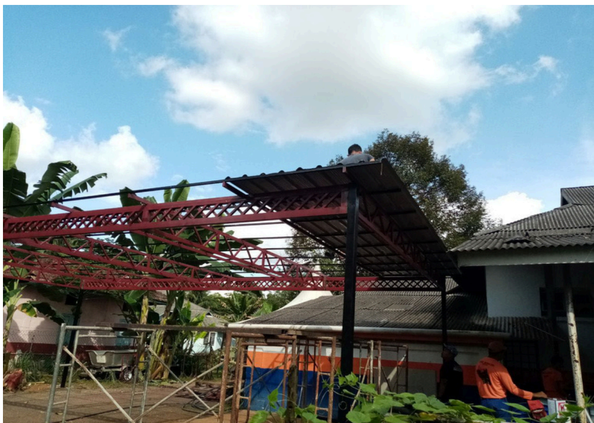
Rajah 14 Proses pemasangan bumbung garaj.
