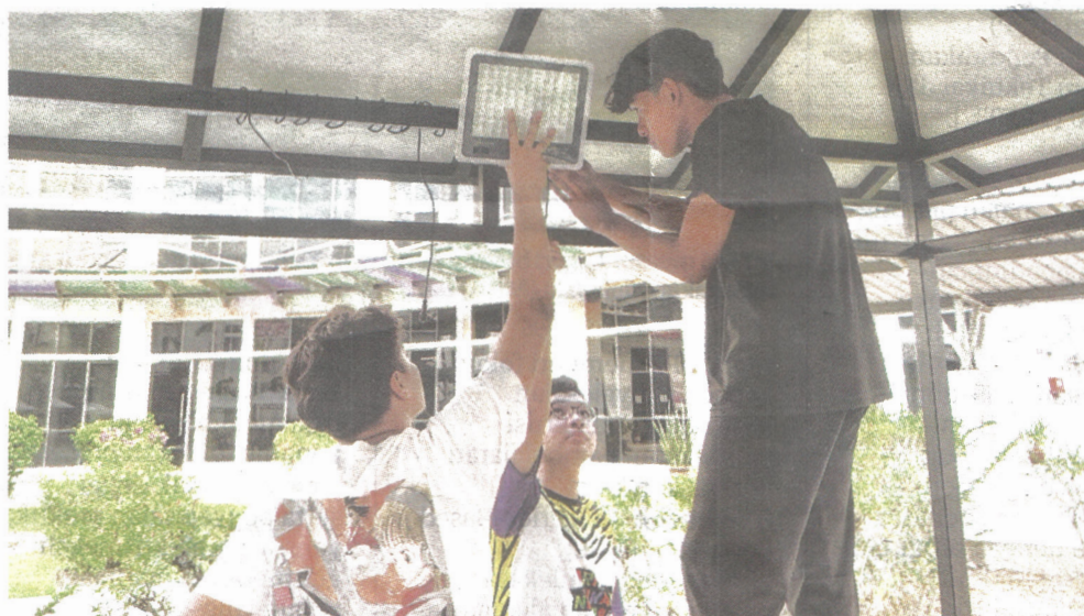
TIGA pelajar Kelab Mesra Alam memasang panel solar pada gazebo sekitar kampus Politeknik Banting Selangor.
