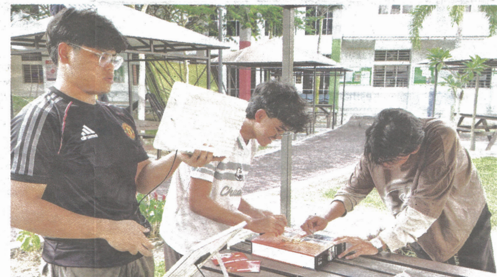
PELAJAR tekun membuat persiapan sebelum kerja kerja pemasangan solar yang memerlukan ketelitian.
