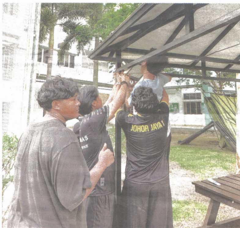
PEMASANGAN panel solar di pilih dalam kawasan di kenal pasti di kampus Politeknik Banting Selangor.
